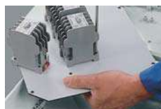
Geräteeinbau auf Montageplatte
