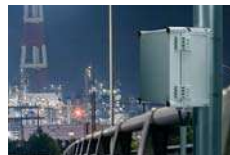
Straßenbeleuchtung in einem Gewerbegebiet
