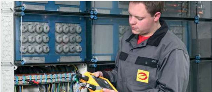
Energie-Schaltgerätekombination (PSC) nach DIN EN 61439-2
