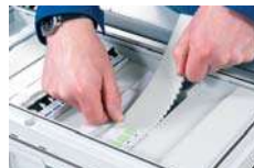
Geräteausschnitte berührungssicher abdecken
