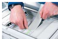
Geräteausschnitte berührungssicher abdecken
