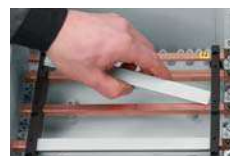
Sammelschienenabdeckung zum Isolieren
