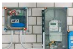
Gehäuse für Kommunikationseinrichtungen zur Übertragung von Messdaten
