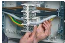
Leiterende mit säure- und alkalifreiem Fett einreiben und sofort anschließen
