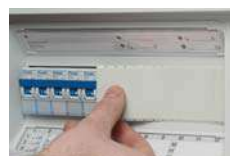
Abdeckstreifen für nicht genutzte Geräteausschnitte
