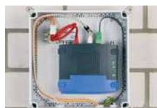
Kommunikationseinrichtung: Router
