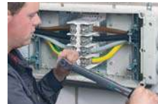
Die Klemmen sind mit dem angegebenen Drehmoment anzuziehen
