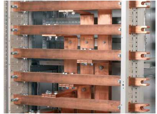
Sammelschienensystem 1250 - 2500 A können optional mit N/PEN-Leiter in gleicher oder höherer Stromtragfähigkeit wie die Außenleiter und EMV-günstig im Bereich der Außenleiter geführt werden.
