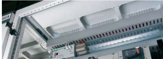
Lüftungshauben im Dachbereich
