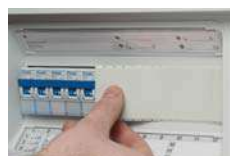
Abdeckstreifen für nicht genutzte Geräteausschnitte
