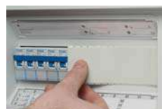
Abdeckstreifen für nicht genutzte Geräteausschnitte
