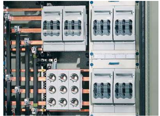
Sammelschienensystem 250 – 630 A werden standardmäßig mit N/PEN-Leiter in gleicher Stromtragfähigkeit wie die Außenleiter und EMV-günstig im Bereich der Außenleiter geführt.
