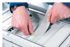
Geräteausschnitte berührungssicher abdecken
