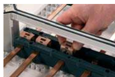
Sammelschienenverbinder
