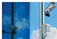
Energieversorgung einer Überwachungskamera im öffentlichen Raum
