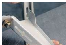
Schritt 1: Einsetzen der unteren Halterung ins C-Profil
