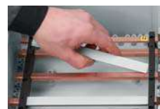
Sammelschienen-abdeckung zum Isolieren
