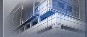
Building Technology / Infrastructure Gebäudetechnik / Infrastruktur
