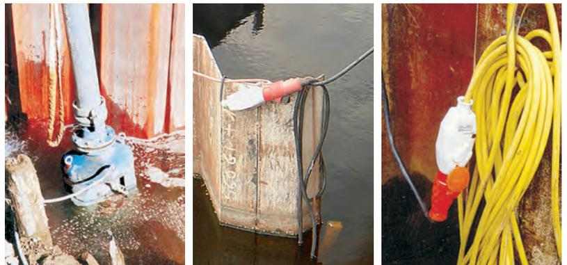
Der NIVA Schwimmerschalter N1 kann überall eingesetzt werden, wo Flüssigkeitsstände überwacht werden müssen. Der Schwimmerschalter N1 ist ein 2-Punkt-Regler und kann auch in Kombination mit der NOLTA Schützkombination, dem NOLTA Motorschutzstecker 230 V, dem NOLTA Kondensatorstecker oder mit Zwischenstecker geliefert werden.
