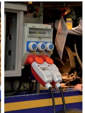
Alle NOLTA Drehknebel sind mit einem Drehknebelschalter mit thermisch-elektromagnetischer Auslösung bestückt. Der angespritzte Steckervorsatz sorgt für maximale Stabilität. Der Motorschutzschalter ist gleichzeitig Ein/Aus-Schalter.
