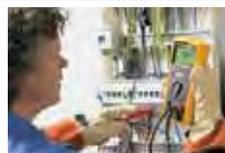
Isolationsprüfung an einer Unterverteilung
