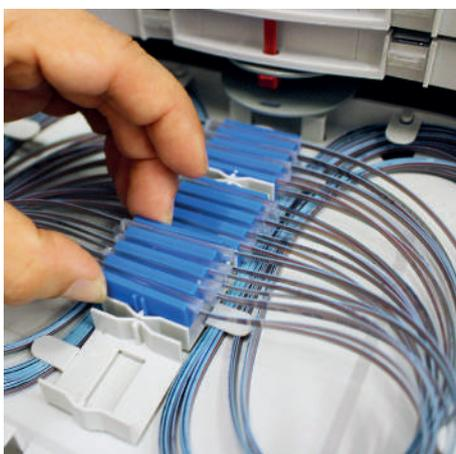
Die Skalierung erfolgt schrittweise über jeweils drei Höheneinheiten (3 HE) mit 288 Ports pro Segment.
