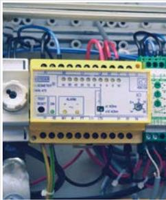
Isolationsüberwachung der 1.000V Strecke, Traforaum zwangsbelüftet
