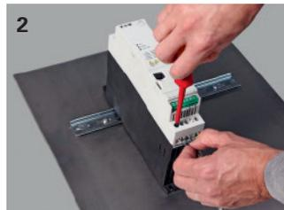
2 Hauptstrombahnen anschließen.
