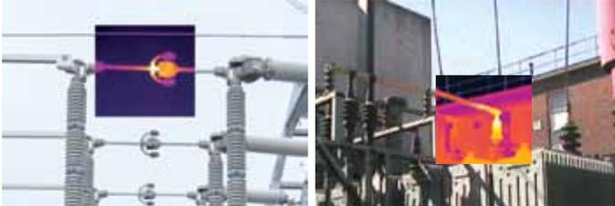
*Bild-im-Bild bietet einen klaren Überblick über diese Hochspannungsanlagen.*
