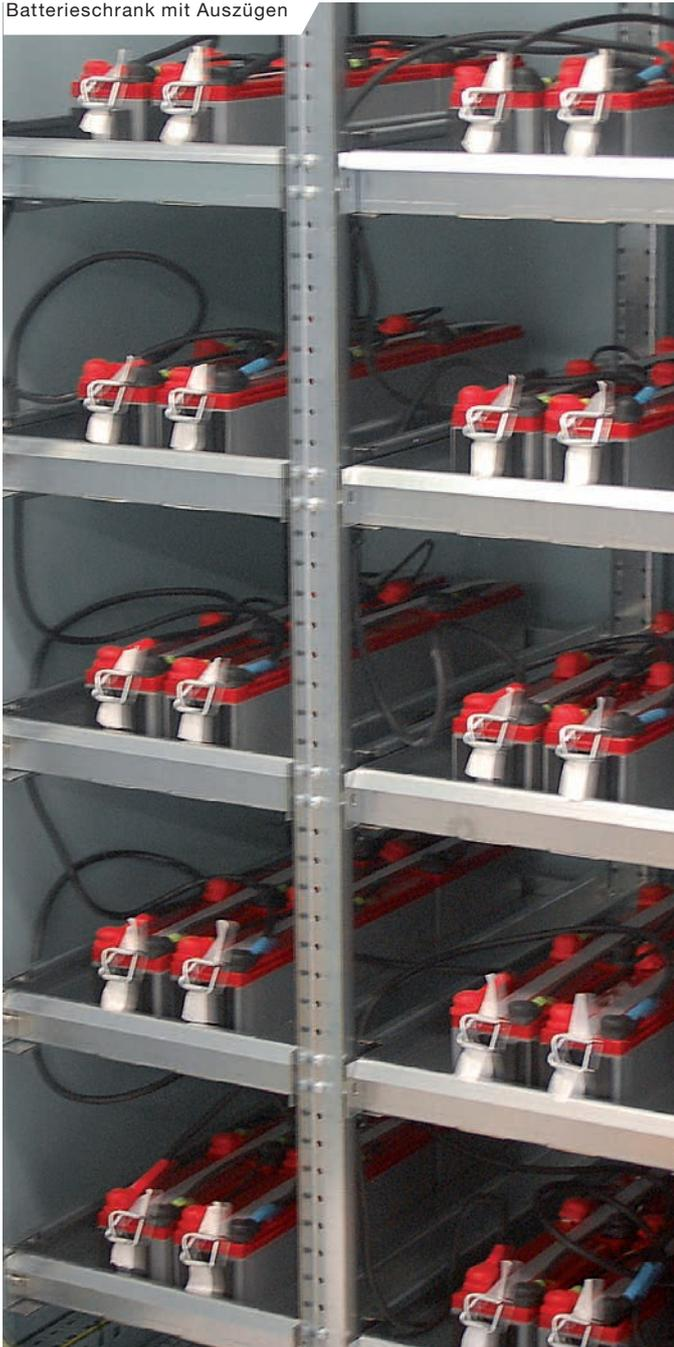
Verschlossene Akkus haben eine typische Lebensdauer von 6 - 9 bzw. 10 – 12 Jahren. Die reale Lebensdauer wird jedoch sehr stark durch Pflege und Umgebungsbedingungen beeinflusst. Grundsätzlich sollten Batterien nicht dauerhaft einer Temperatur von über 25°C ausgesetzt werden, da dann die Lebensdauer erheblich sinkt.
