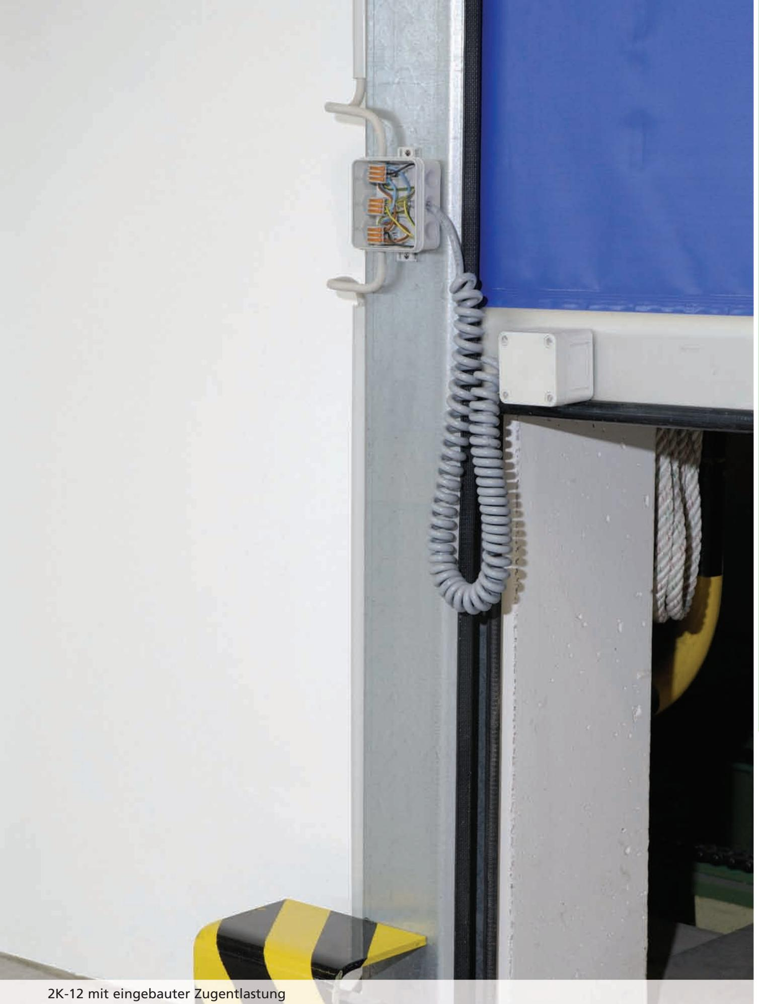
2K-12 mit eingebauter Zugentlastung
