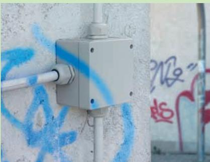
Nach DIN EN 50102 (VDE 0470-100) „Schutzarten durch Gehäuse für elektrische Betriebsmittel (Ausrüstung) gegen äußere mechanische Beanspruchungen (IK-Code)“ wird der durch ein Gehäuse realisierte Schutzgrad gegen mechanische Beanspruchungen durch den sogenannten IK-Code angegeben. Die den einzelnen Beanspruchungsenergiewerten zugeordneten IK-Codes sind der untenstehenden Tabelle zu entnehmen. Die Angaben der IK-Werte der einzelnen els-Produkte sind Tabelle 1 (Seite 416) zu entnehmen.
