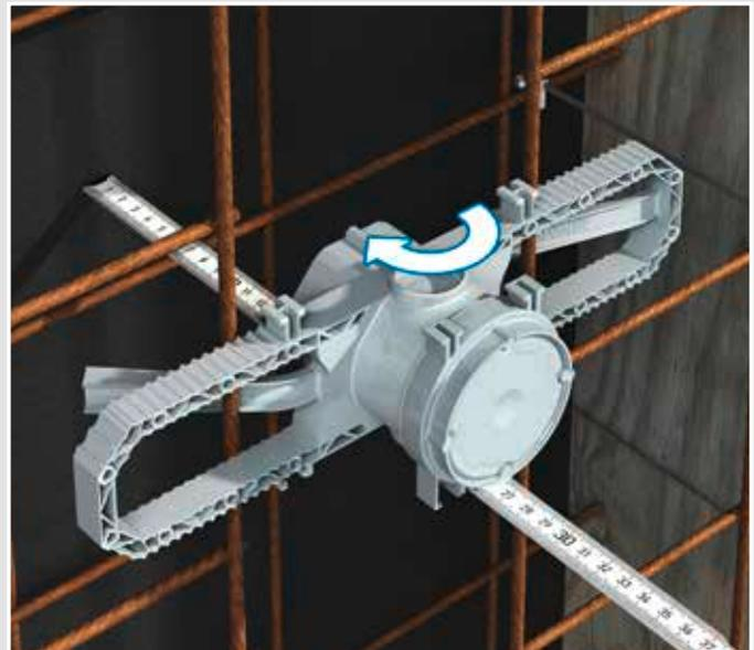
Die Frontseite der Geräte-Verbindungsdose muss zwischen 5 und 20 mm über die Wandstärke hinausragen, somit wird ein optimaler Druck auf die Gegenschalung erzeugt.
