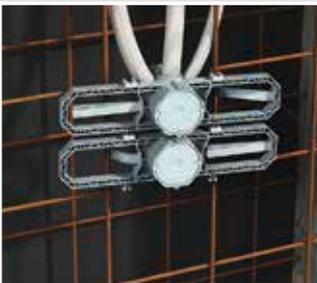
Rohre einbringen und Dose mit Prefix®-Montagetechnik in der Bewehrung einfach und schnell vorfixieren.
