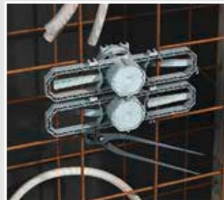
...um die Befestigung an der Bewehrung mit Rödeldraht schnell und sicher auszuführen.
