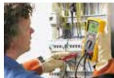
Isolationsprüfung an einer Unterverteilung
