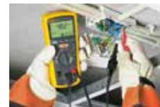
Verdrahtungsprüfung in einem kleinen Verteilerschrank
