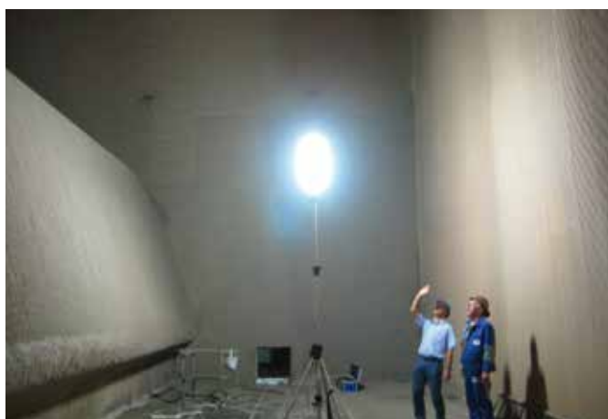
ApolloLIGHT - Ausleuchtung Kessel
