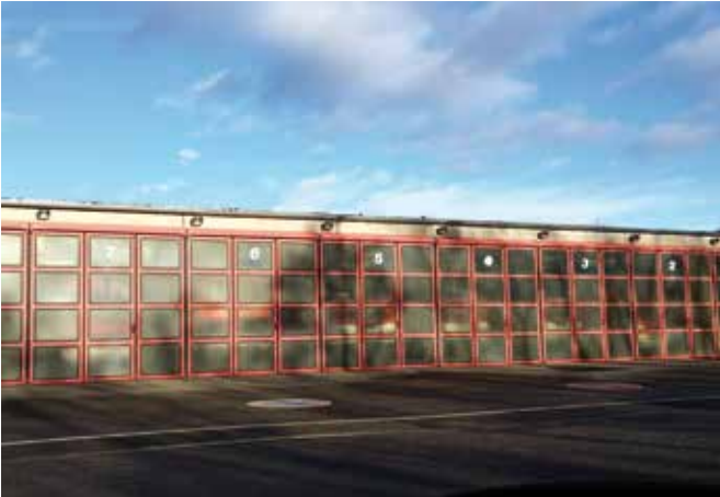
FlutLED 50 Watt - Beleuchtung Gerätehallen, Werksfeuerwehr
